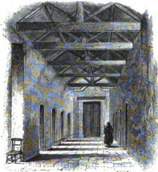
Corridor in San Marco.
